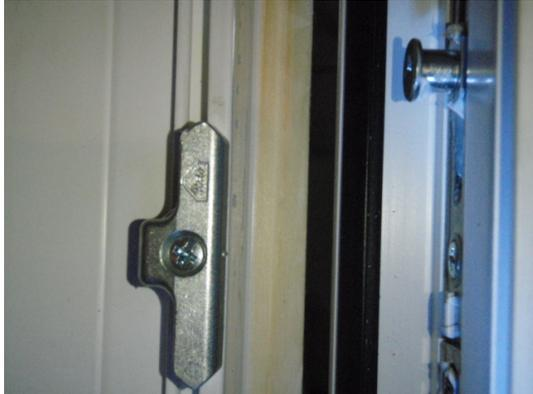
**Bild 20** Verriegelungssituation Blendrahmen / Flügelrahmen - Pilzzapfen
