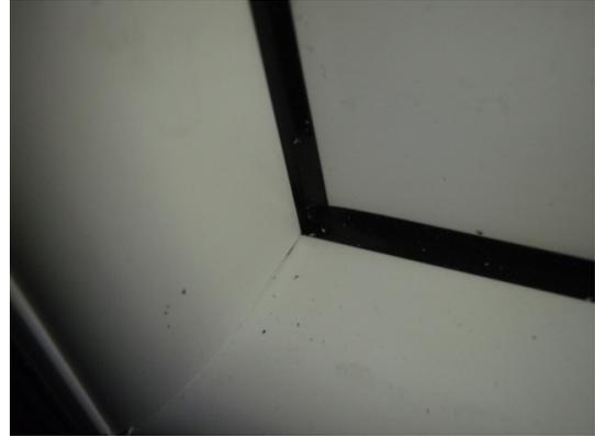
**Bild 17** Innere Verglasungsdichtung Eckausbildung am Paneel
