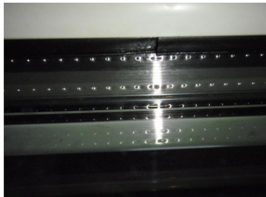
**Bild 12** Äußere Verglasungsdichtung Dichtungsstoß
