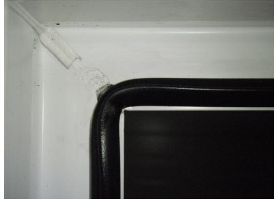
**Bild 6** Äußere Anschlagdichtung, Eckausbildung
