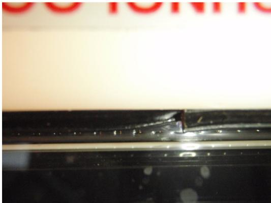
**Bild 13** Äußere Verglasungsdichtung
