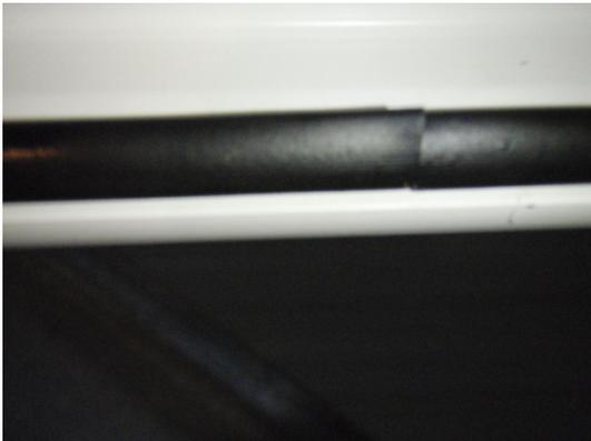
**Bild 7** Äußere Anschlagdichtung, Dichtungsstoß
