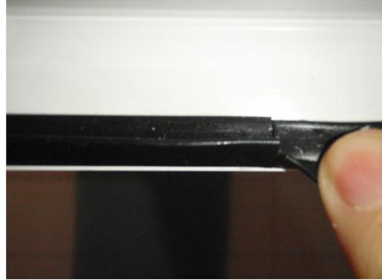
**Bild 6** Äußere Anschlagdichtung, Dichtungsstoß
