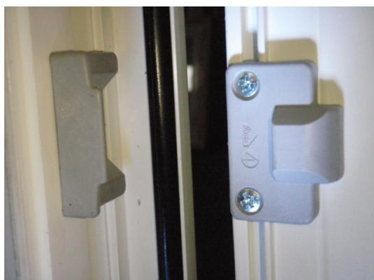
**Bild 21** Verriegelungssituation Blendrahmen / Flügelrahmen 1, Innenansicht Standflügel
