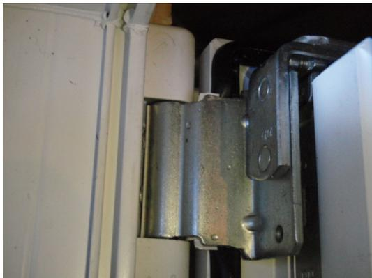
**Bild 17** Scherenlager, Falzansicht
