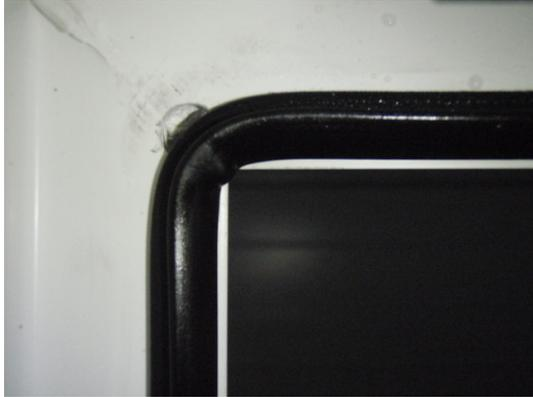
**Bild 4** Äußere Anschlagdichtung,
