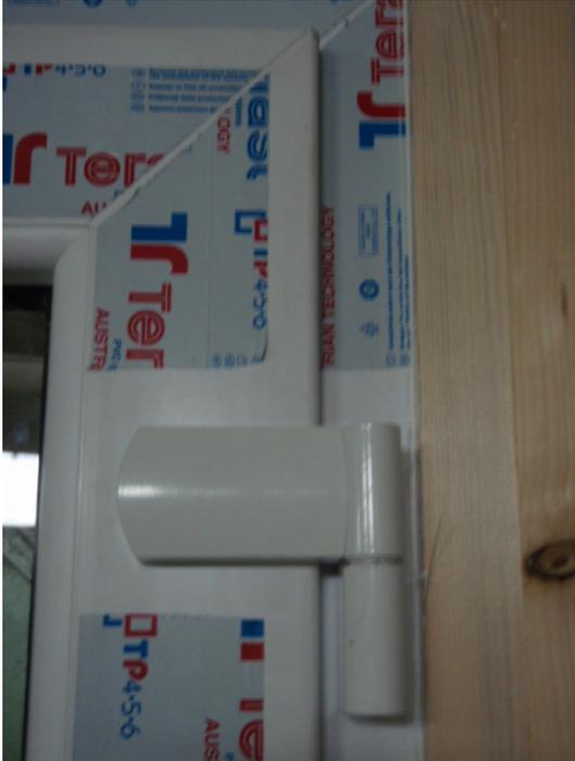
**Bild 21** Drehband, Innenansicht
