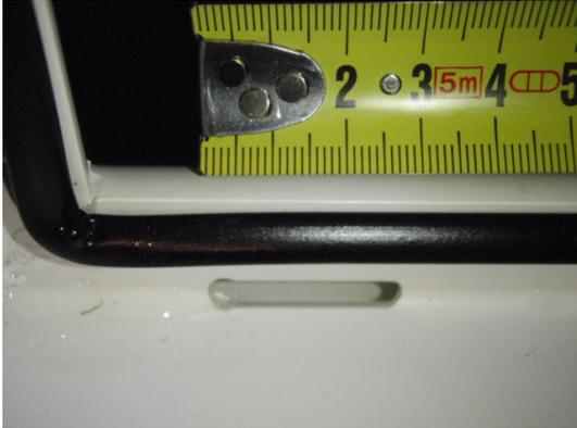
**Bild 5** Falzentwässerung
