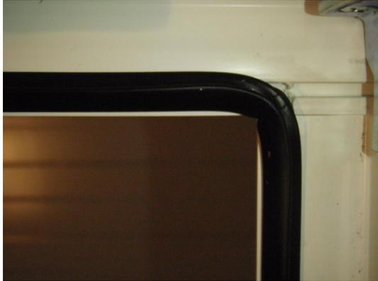
**Bild 5** Äußere Anschlagdichtung, Eckausbildung
