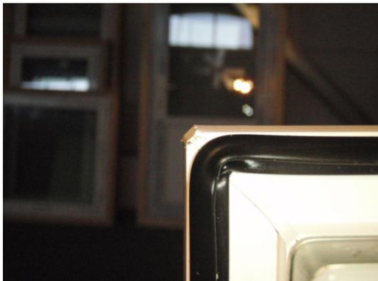
**Bild 7** Innere Anschlagdichtung, Eckausbildung
