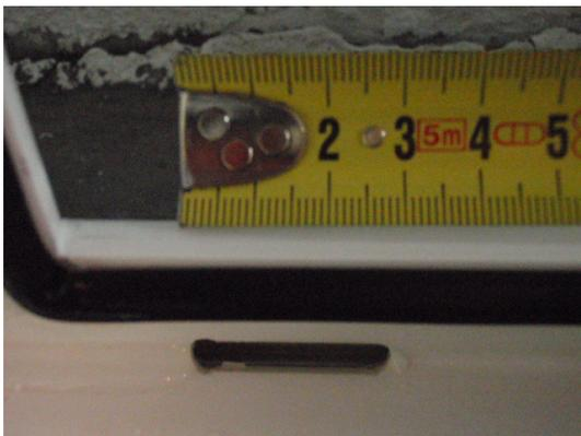
**Bild 3** Falzentwässerung
