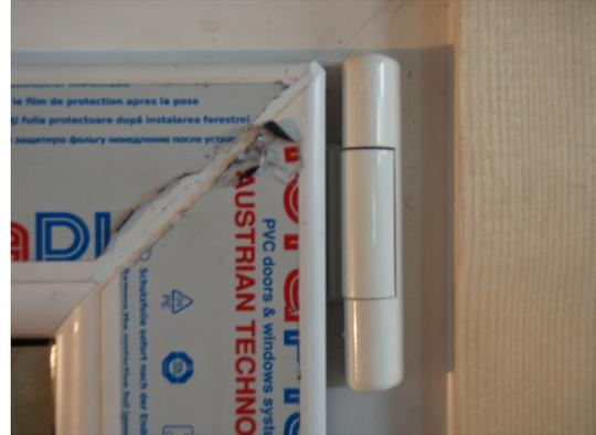
**Bild 16** Scherenlager, Innenansicht
