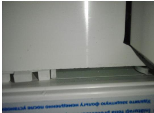
**Bild 19** Ansicht Glasfalz horizontal am Paneel
