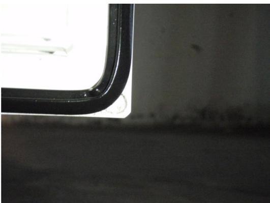
**Bild 8** Innere Anschlagdichtung Eckausbildung
