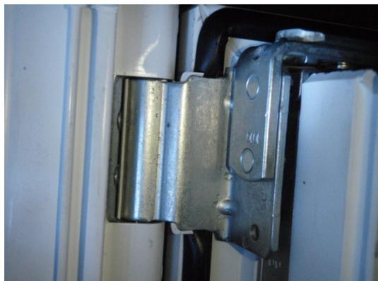
**Bild 14** Scherenlager, Falzansicht
