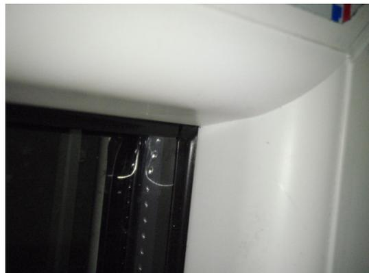
**Bild 14** Innere Verglasungsdichtung
