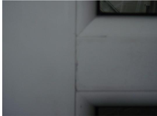
**Bild 10** Abdichtung Pfostenprofil, Innenansicht
