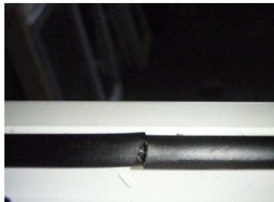
**Bild 8** Innere Anschlagdichtung
