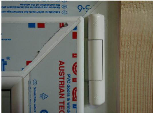
**Bild 17** Scherenlager, Innenansicht
