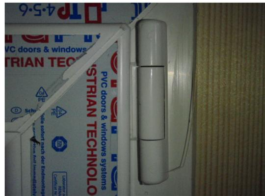
**Bild 13** Scherenlager, Innenansicht
