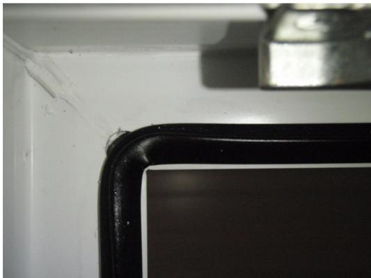
**Bild 5** Äußere Anschlagdichtung,
