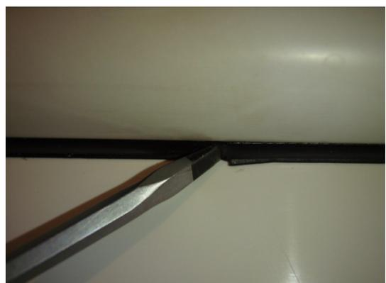
**Bild 15** Äußere Verglasungsdichtung Dichtungsstoß am Paneel
