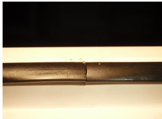
**Bild 8** Innere Anschlagdichtung, Dichtungsstoß
