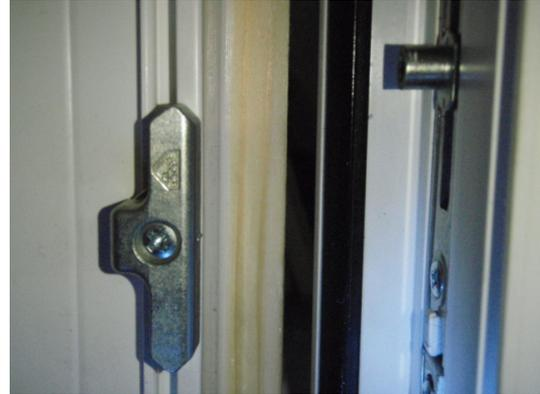
**Bild 21** Verriegelungssituation Blendrahmen / Flügelrahmen - Rundzapfen
