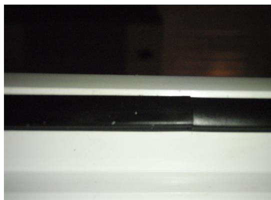
**Bild 9** Innere Anschlagdichtung Dichtungsstoß
