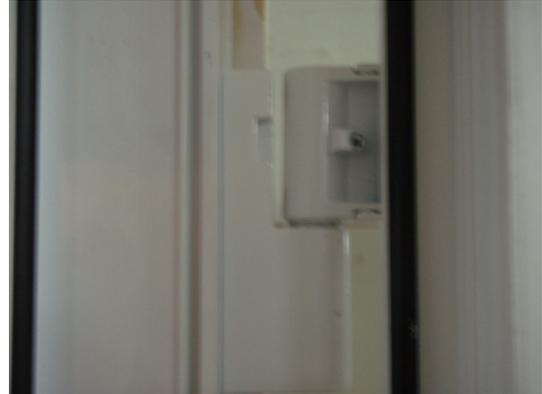
**Bild 22** Drehband, Falzansicht
