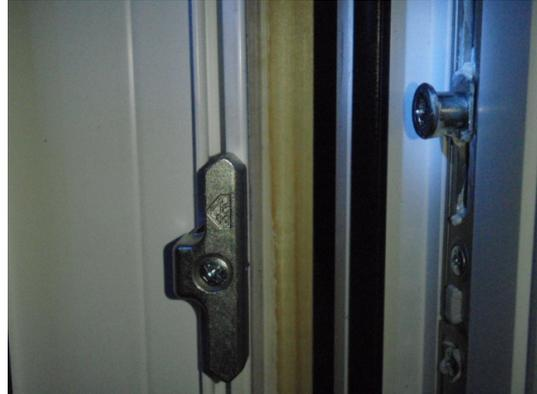
**Bild 17** Verriegelungssituation Blendrahmen / Flügelrahmen - Pilzzapfen
