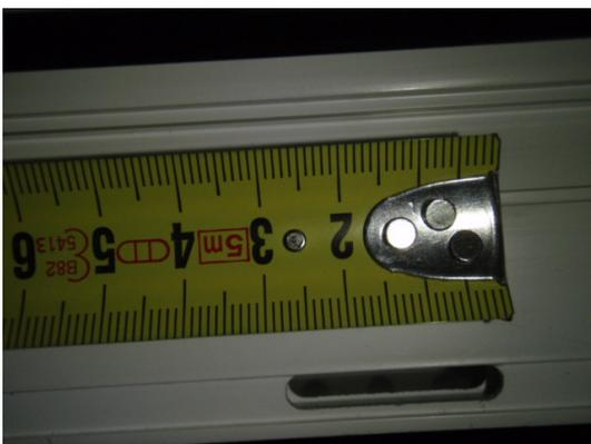
**Bild 20** Dampfdruckausgleich
