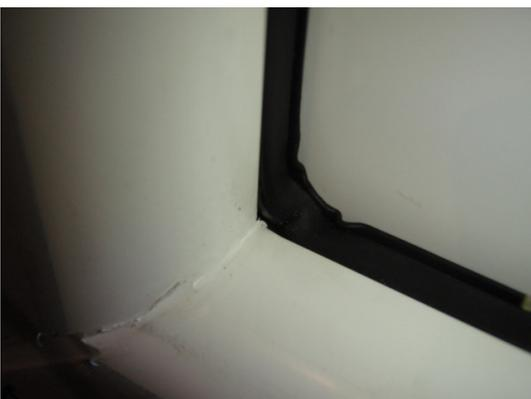
**Bild 14** Äußere Verglasungsdichtung Eckausbildung am Paneel
