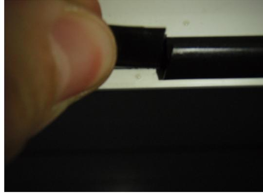
**Bild 5** Äußere Anschlagdichtung,
