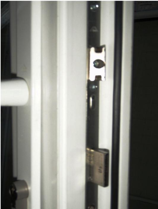
**Bild 32** Falle und Schließzylinder
