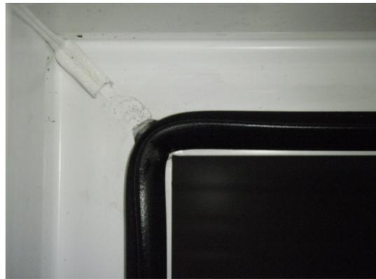
**Bild 4** Äußere Anschlagdichtung, ECKausbildung
