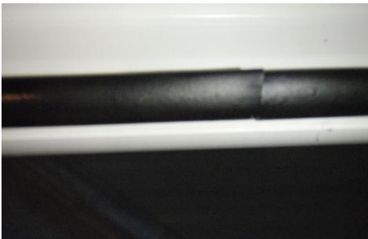
**Bild 5** Äußere Anschlagdichtung, Dichtungsstoß
