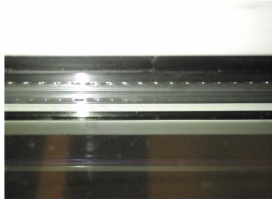
**Bild 8** Äußere Verglasungsdichtung, Dichtungsstoß
