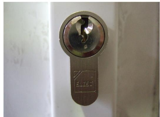
**Bild 29** Profilzylinder Elzett
