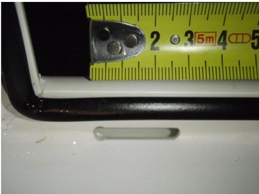
**Bild 3** Falzentwässerung
