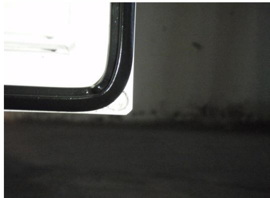
**Bild 6** Innere Anschlagdichtung ECKausbildung
